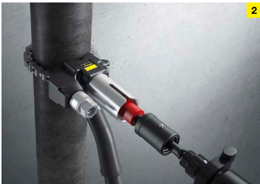
2. Wykonać otwór wiertarką i ściągnąć prowadnicę wiertarską.
